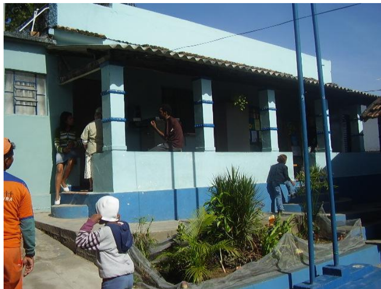
Figura 1: prédio principal da escola
