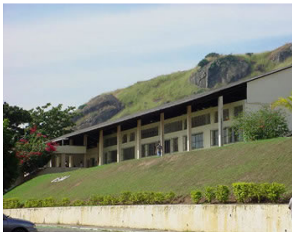
Nº. 03- Parte externa do prédio das cantinas. (Fonte: http://www.ffp.uerj.br/ )
